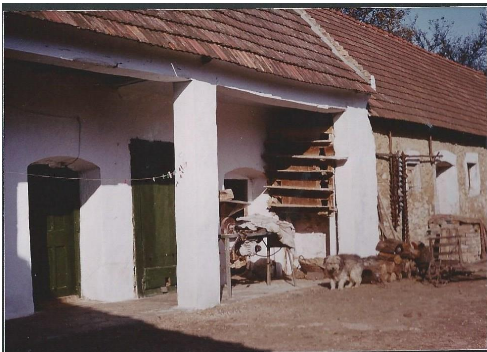
A gádor vége a beépített galambházzal
