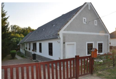
Hitelesen felújított népi lakóépület
