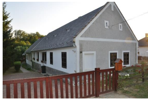
Kossuth L.u.29. Hitelesen felújított népi lakóépület
